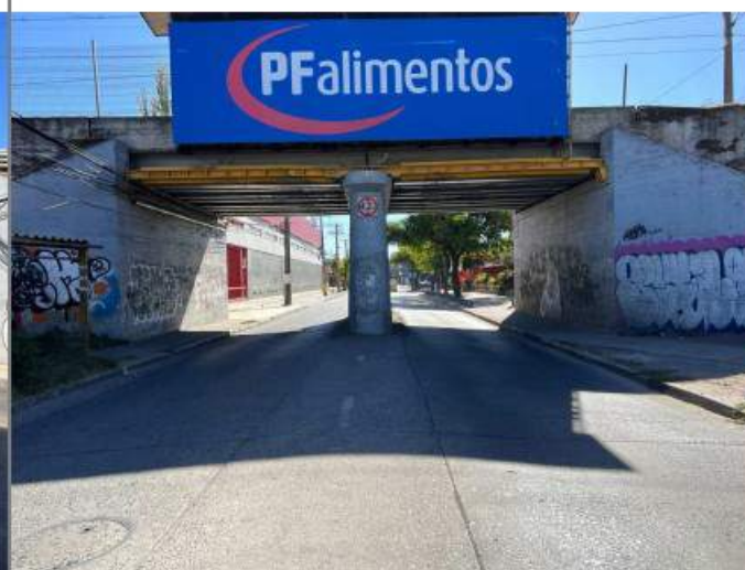
Figura 3. Estado actual paso bajo nivel 2 norte.
