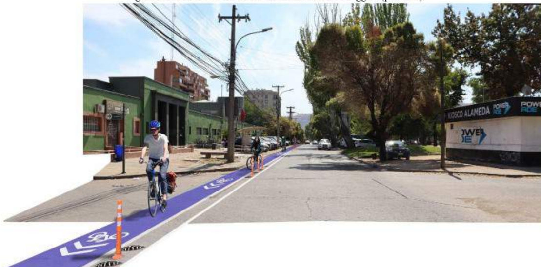
Figura 2. Construcción ciclovía alameda Bernardo O'Higgins (pista sur).
