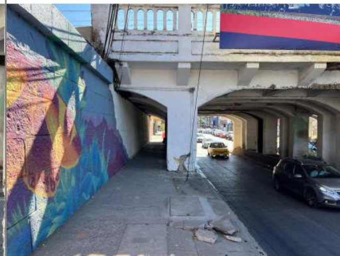
Figura 3. Estado actual paso bajo nivel 1 norte.
