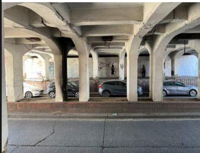
Figura 2. Estado actual paso bajo nivel 1 norte.
