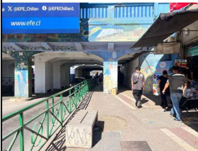
Figura 2. Estado actual paso bajo nivel 1 sur.
