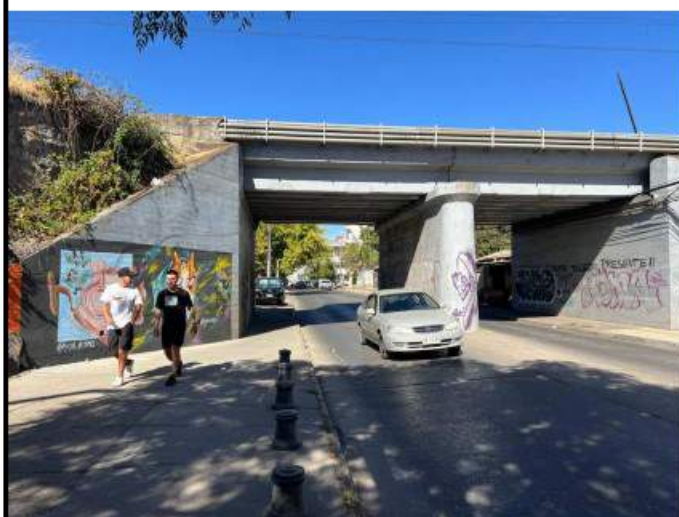
Figura 2. Estado actual paso bajo nivel 2 norte.
