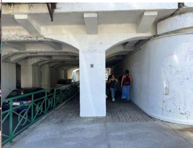
Figura 2. Estado actual paso bajo nivel 1 sur.
